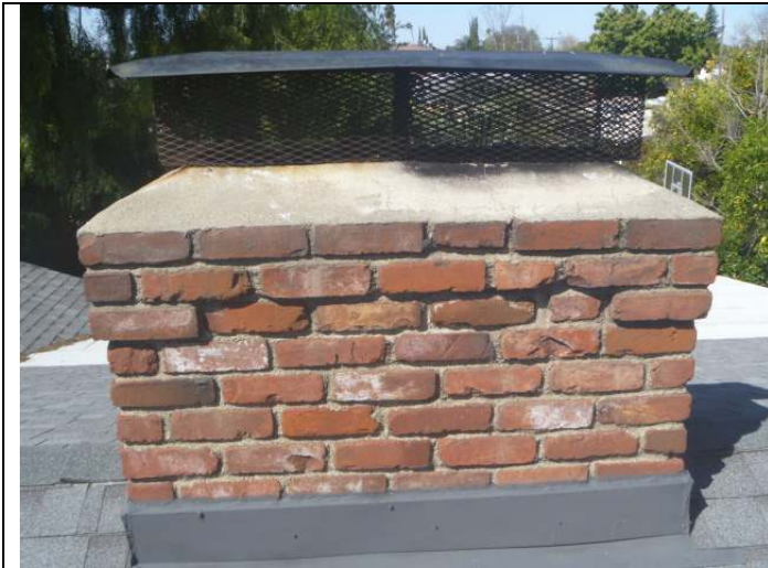
Chimney upper exterior.
