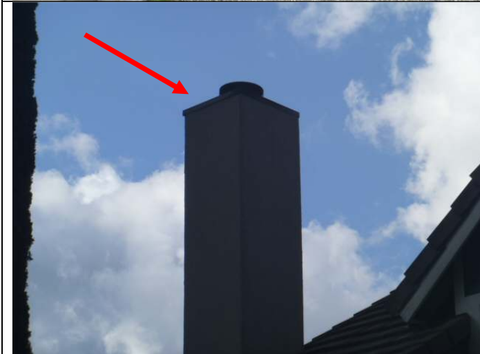
Chimney upper exterior.
