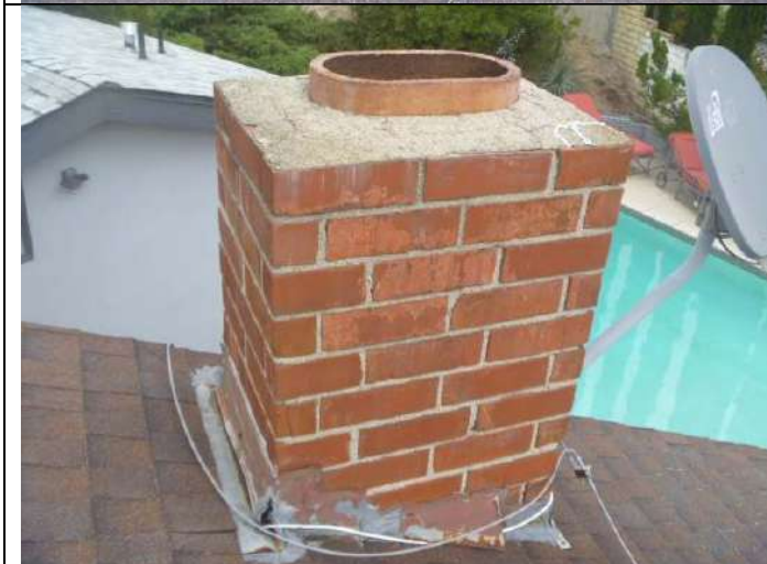
Chimney upper exterior.
