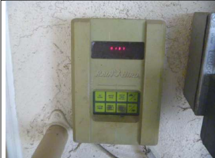
Indoor type sprinkler timer.
