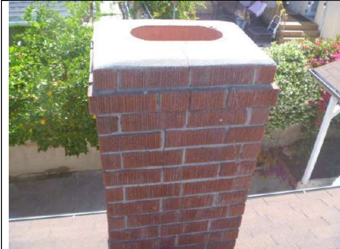
Chimney upper exterior.
