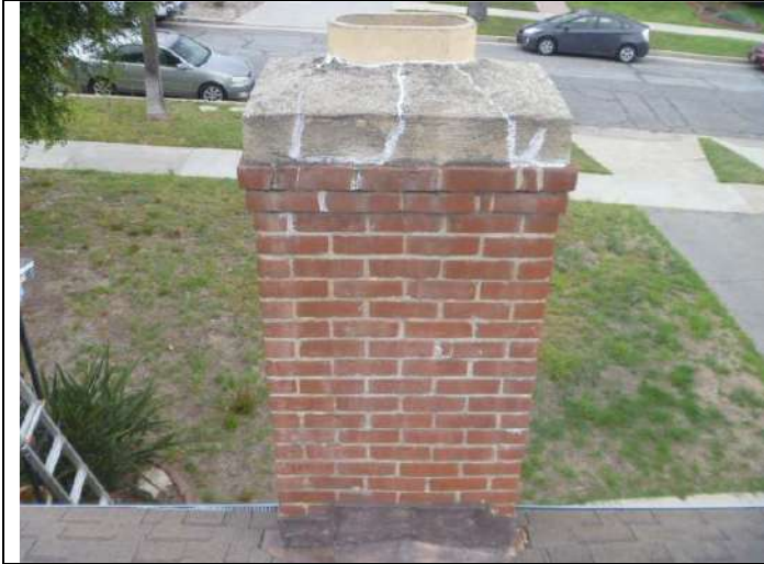
Chimney upper exterior.
