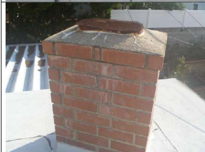
Chimney upper exterior.
