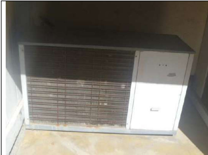
Air conditioner condensing unit.
