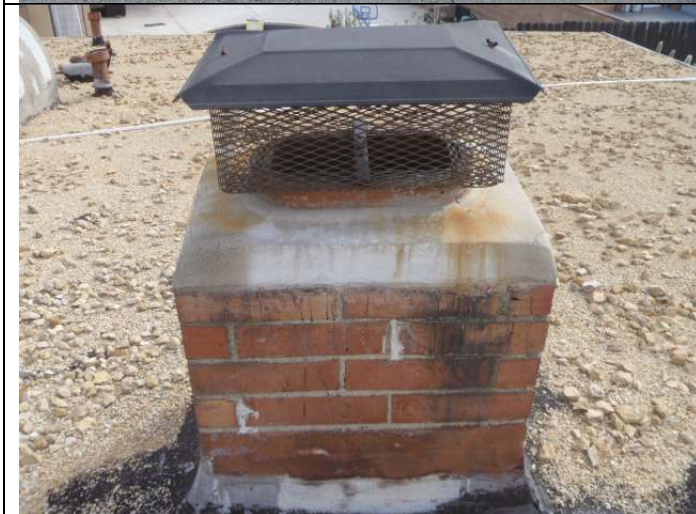
Chimney upper exterior.
